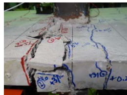
床スラブひび割れ
